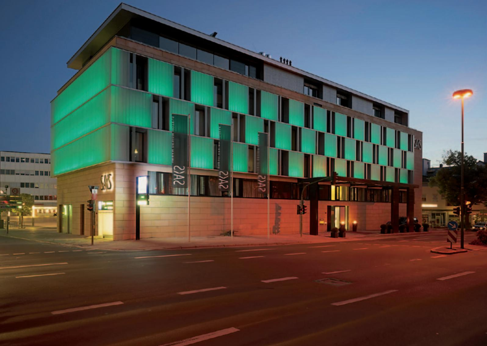
Eine Sockelzone aus gelbem Sandstein, eine Gebäudehülle aus Profilitglas und ein abgesetzter Dachbereich sorgen für eine harmonische Gliederung des Gebäudes. Die kristalline Glasfassade wird nachts farbig hinterleuchtet und verleiht dem Haus eine einzigartige Ausstrahlung.
