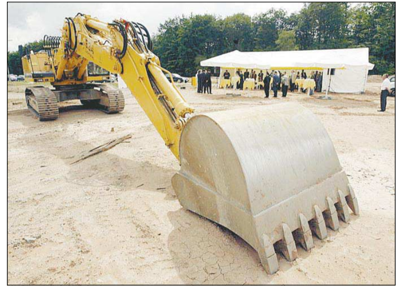
Der Bagger steht bereit: Die Bauarbeiten für das „monte-mare“-Bad auf dem Hochplateau im PRE-Park sind gestern begonnen worden. —FOTO: VIEW
