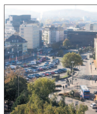
Die Maxstraße (rechts) und die danach folgende Pariser Straße sollen künftig wieder in beiden Richtungen befahrbar sein.
