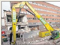
Am früheren Postgebäude laufen Abrissarbeiten. FOTO: VIEW
