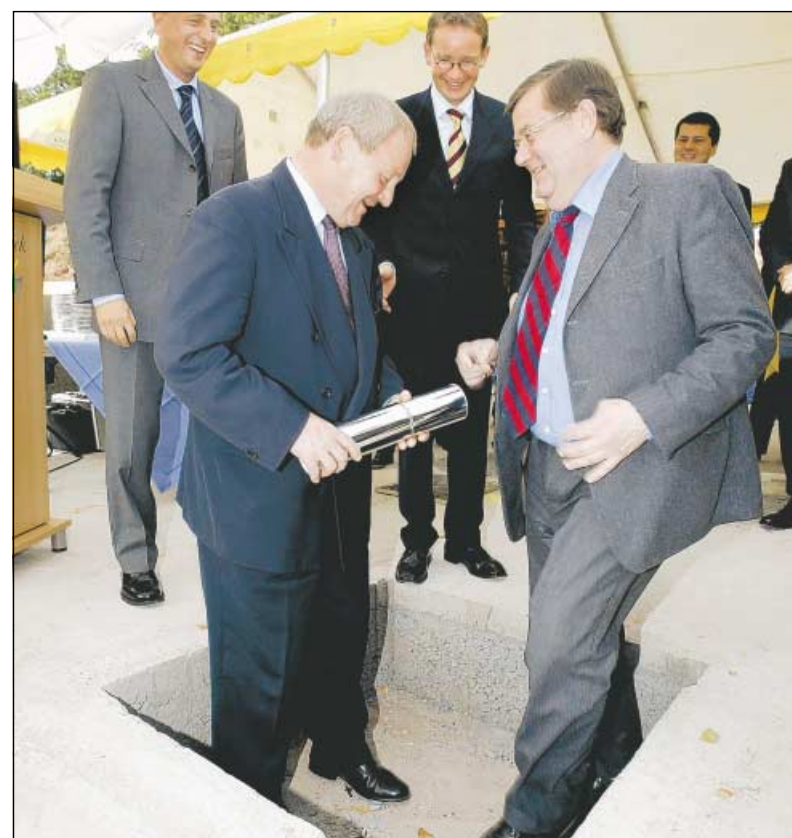
Einbetoniert: die Hülse, die vom Mainzer Innenminister Walter Zuber (links) und Oberbürgermeister Bernhard Deubig gestern in das Fundament des monte-mare-Freizeitbades gelegt wurde.
