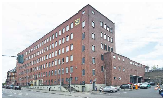
Ab Oktober sollen die ersten Asylbewerber in die ehemalige Hauptpost nahe dem Hauptbahnhof einziehen. Das Gebäude muss noch sukzessive renoviert werden. FOTO: VIEW
