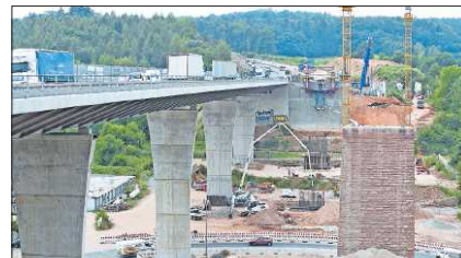
Der zweite Teil der Lautertalbrücke nimmt langsam Gestalt an, ein alter Pfeiler bleibt stehen.
