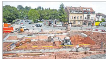
Wenn alles glatt läuft, soll der Neubau der TAS bis Ende des Jahres fertig sein.
