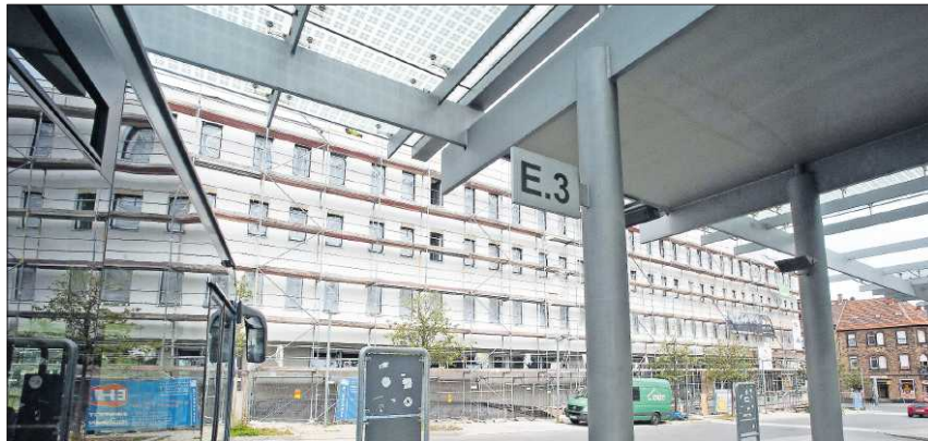
Der viergeschossige Neubau am Guimaraes-Platz am Hauptbahnhof steht vor der Fertigstellung.
