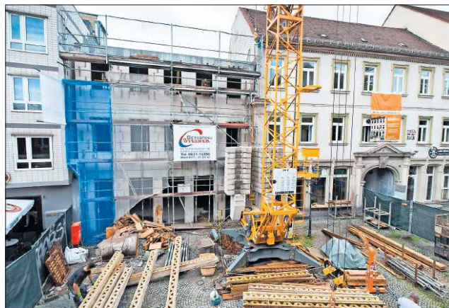
Auf dem Weg zu einem neuen Hannen-Fass kommt Bauherr Jürgen lang gut voran.
