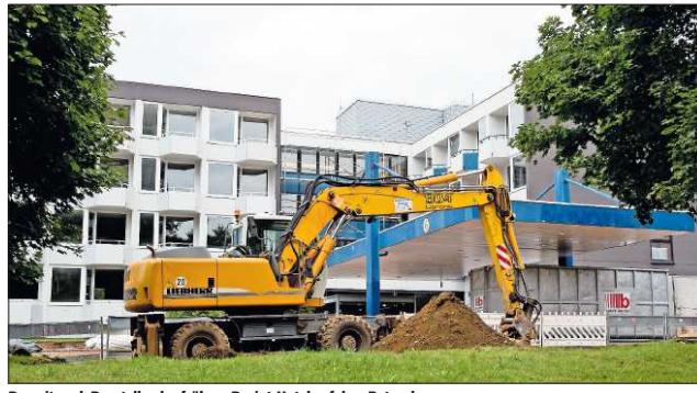
Derzeit noch Baustelle: das frühere Dorint-Hotel auf dem Betzenberg.
